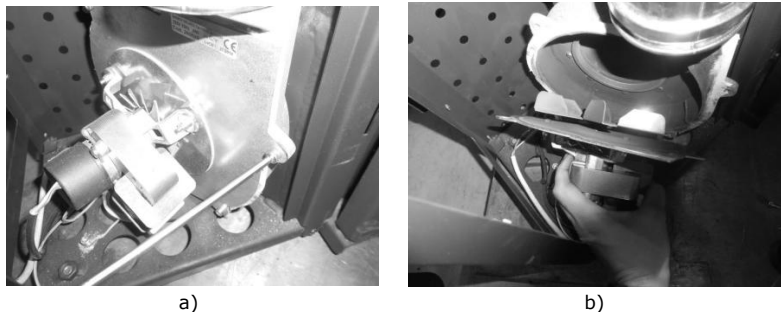
Figure 19 - a) Retrait des vis; b) Sortir l'extracteur des fumées
