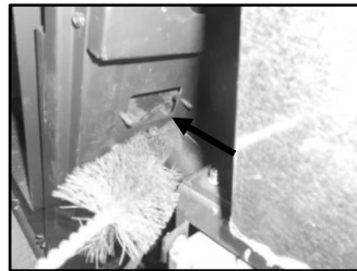
Figura 18 - a) Aspirar el interior; b) Limpieza con cepillo
