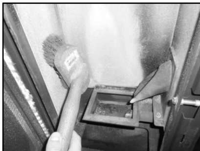
Figura 15 - Limpieza del interior
