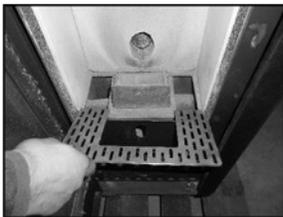
**Figura 41 – Remoção da grelha de cinzas**
