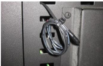
**Figura 21 – Sonda de temperatura ambiente**
