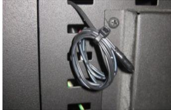
**Figure 21 – Sonde température ambiante**
